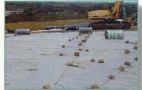
Pose du drainage sur GSB
