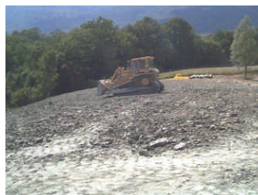
Régalage et compactage de la couverture argileuse
