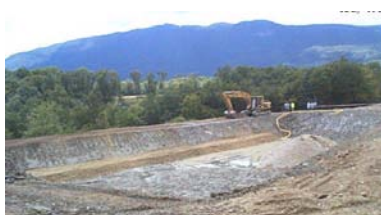
Travaux de drainage sur la classe 3.
