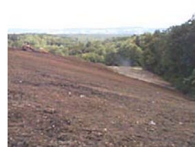
Mise en place de la terre végétale
