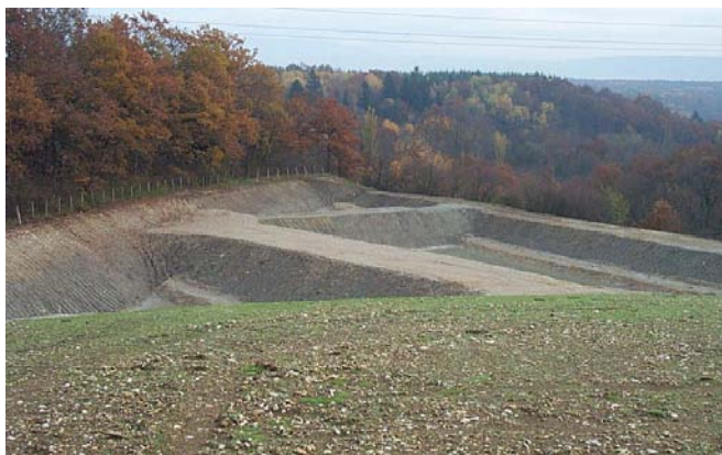
1er plan : Prise de la végétation sur l'ancienne décharge remise en état. Arrière plan : Centre de Stockage de Déchets Inertes.
