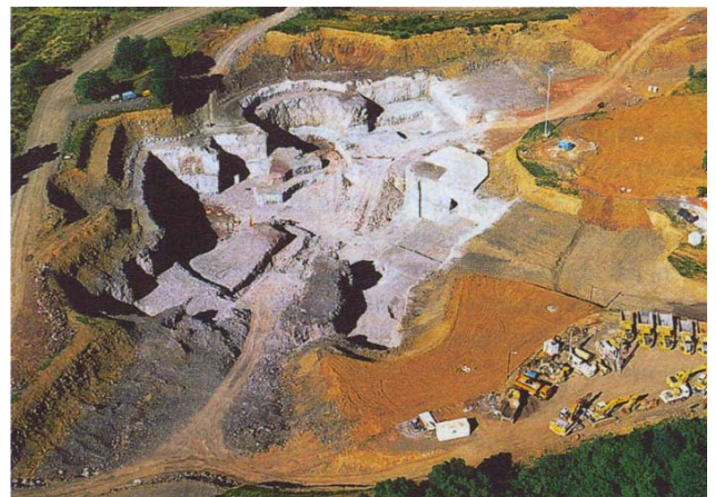
Le site, avec en bas à droite, l'aire de chantier étanche
